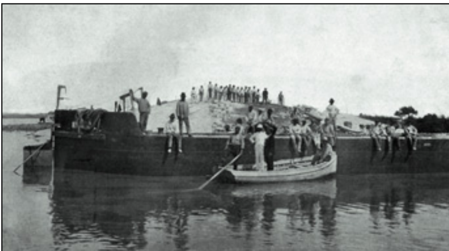
Construcción de la defensa en la boca del canal de acceso al puerto de ultramar.
