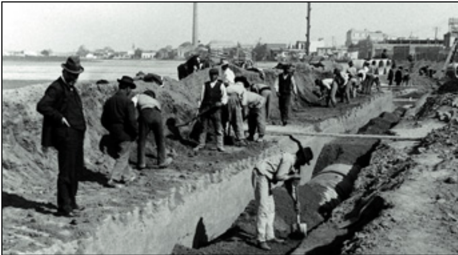
Tareas de tendido de redes primarias en el obraje.
