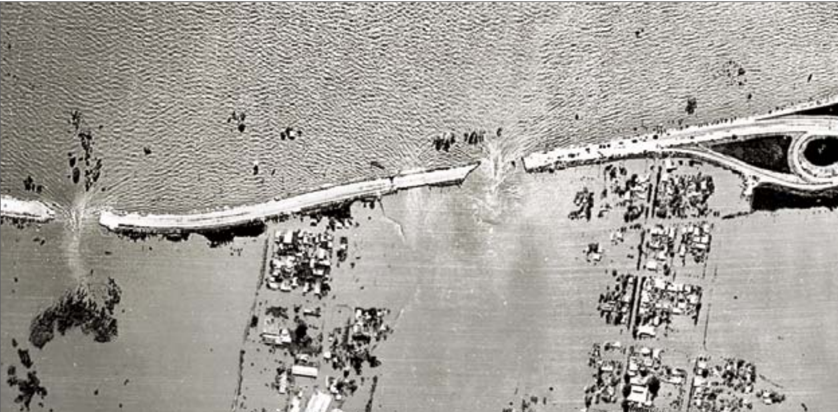
Ruta Nacional 168 durante la crecida de 1983 Puentes aliviadores 4 y 6 destruidos y La Guardia inundada.
