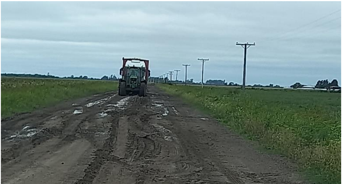
♦ Vía de comunicación de tierra, sin red de drenaje, tractor remolcando camión con granos a piso firme, en el centro sur del departamento General Obligado.
